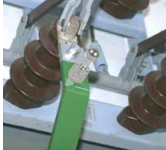
Rak fast kulbult monterad på fasskena.
