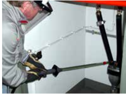
Påfyllning av varm isolationsolja under spänning.
