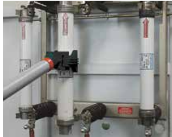
Vinklad SZ säkringstång för montering och demontering av h.v.h.b.c. säkringar.
